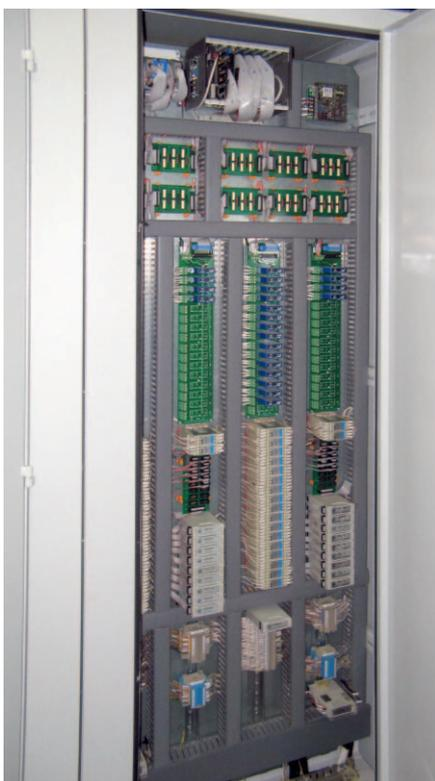
Рис. 4. Монтаж аппаратных средств АСУ
