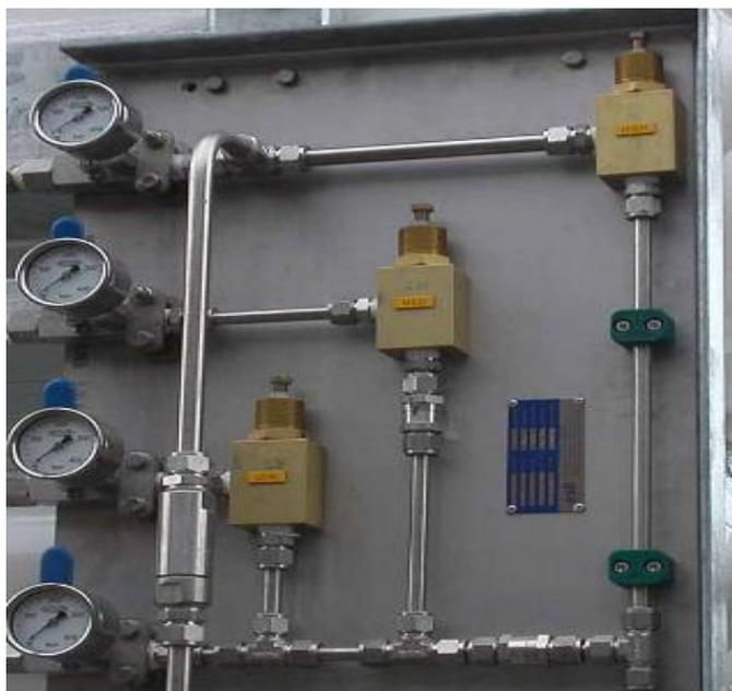
Для того, чтобы увеличить эффективность аккумуляторов сжатого газа и сократить время самой заправки автомобилей, используются трехлинейная система. Принцип трехлинейной системы заключается в том, что хранение сжатого метана производится в трех отдельных группах ресиверов, которые могут быть заполнены и опорожнены независимо друг от друга. Эти каскады обозначены тремя уровнями: низкий, средний и высокий уровень.
